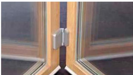
Изменяемая по высоте шарнирная петля, вид снаружи; скрытое крепление для повышенной противовзломности.
