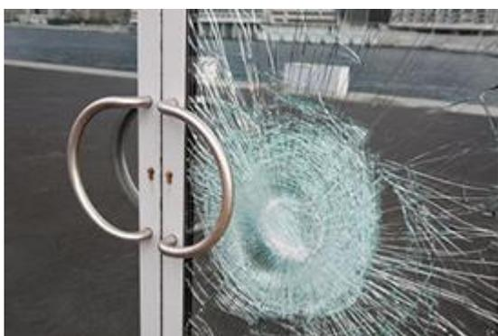
На стекло нанесена защитная пленка А3, обладает большей механической прочностью и повышенной безопасностью: даже если по нему будет нанесен удар такой силы, что стекло разобьется, оно не разлетится на острые и опасные осколки – их удержит прочная защитная пленка. Эта особенность обеспечивает ещё одно важное преимущество: если безопасное стекло разбито или треснуло в результате механического воздействия, оно может продолжать выполнять ограждающую функцию до момента замены стеклопакета.
